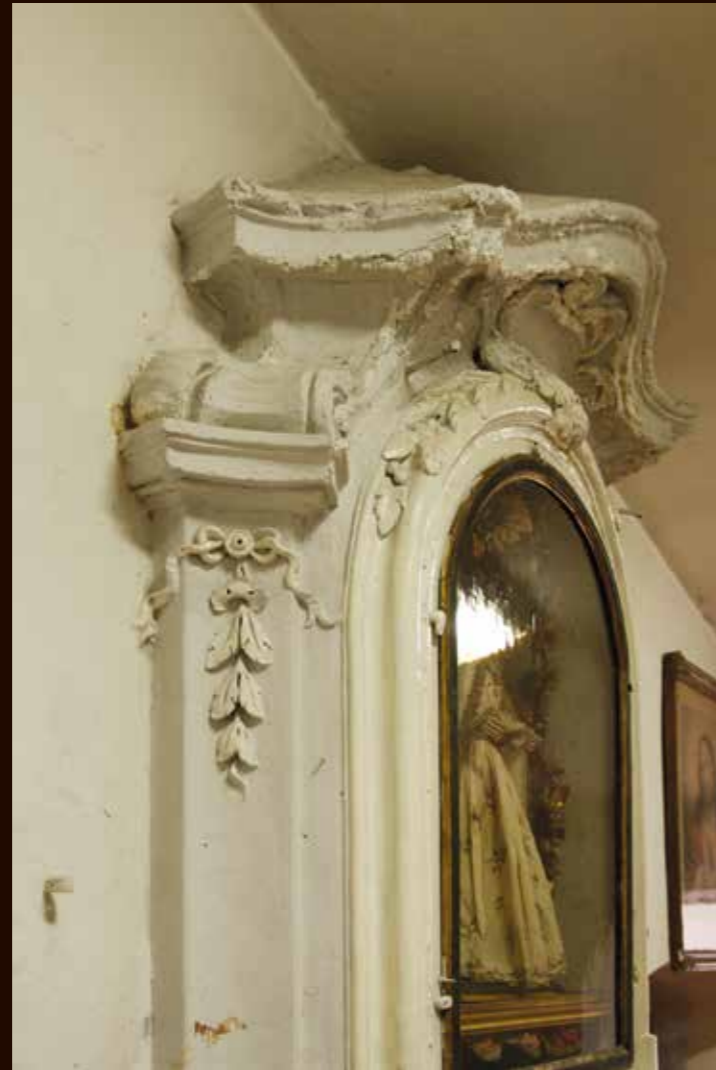
Autore ignoto | Edicola con Madonna | Secolo XVII Convento delle Grazie | Massa-Carrara | 2016 | Restauro edicola in stucco con statua di Madonna vestita. Descialbo completo dell'edicola in stucco policromo, consolidamento, trattamento antisale, stuccatura e ritocco pittorico. Restauro portina in legno e colomba in cartapesta, montaggio e risistemazione della statua della Madonna. Autorizzazione Soprintendenza di Lucca e Massa-Carrara.
